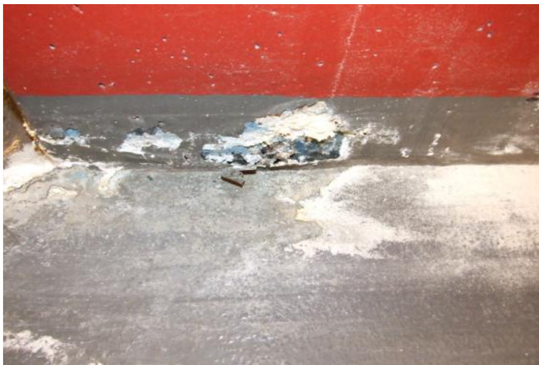
Figur 30 Betongskador på pelare C4 orsakat av armeringskorrosion (Foto: B Sederholm)
