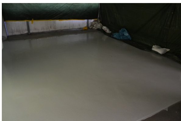
Figur 28 Färdig provyta med Mapefloor PU Flexibinder samt provplatta (Foto: Y Edwards)
