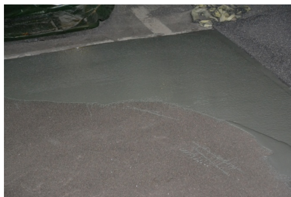
Figur 12 Topplack påförs beläggnings (Foto: Y Edwards)
