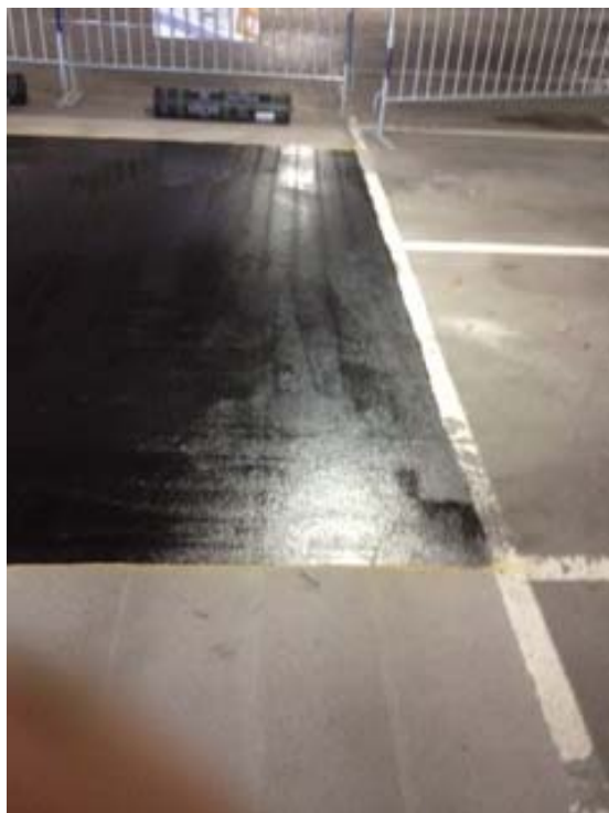
Figur 6 Provyta behandlad med bitumenprimer (t v) och svetsapplicering av matta (t h) (Foto: Duo Asfalt)
