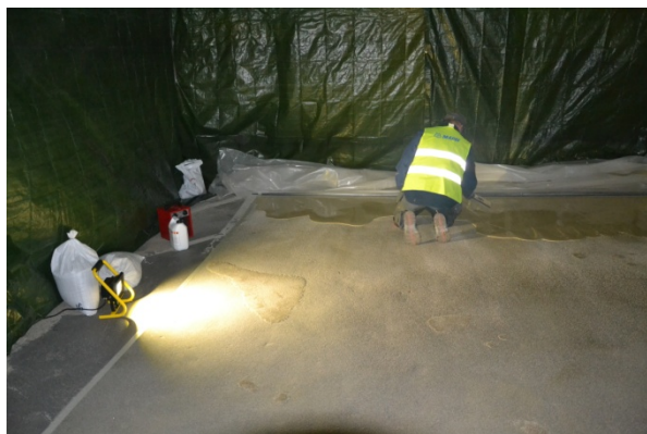
Figur 27 Mapefloor PU Flexibinder under utläggning respektive härdning (Foto: Y Edwards)
