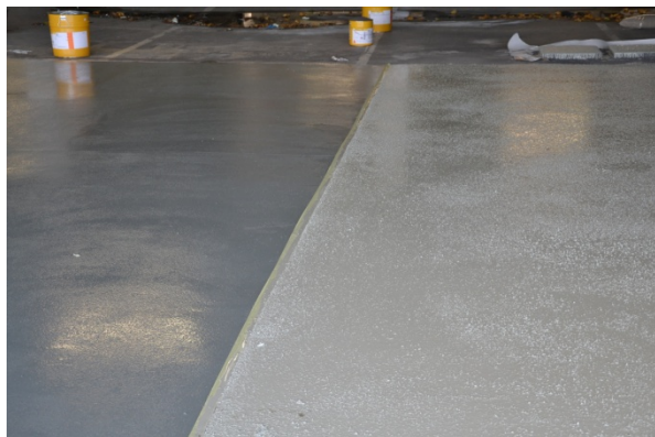
Figur 13 Färdig grå provyta Sikafloor 375 med topplack (Foto: Y Edwards)
