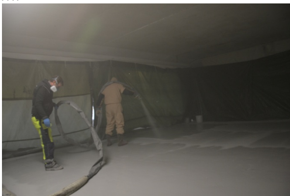
Figur 25 Polyurea Micorea S3 sprutappliceras med ordentligt skydd omkring provytan (Foto: Y Edwards)
