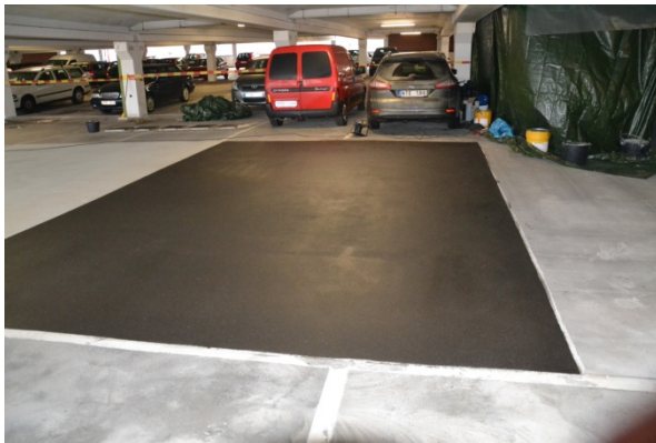
Figur 24 Färdig provyta med Map Pro Flexibinder (Y Edwards)
