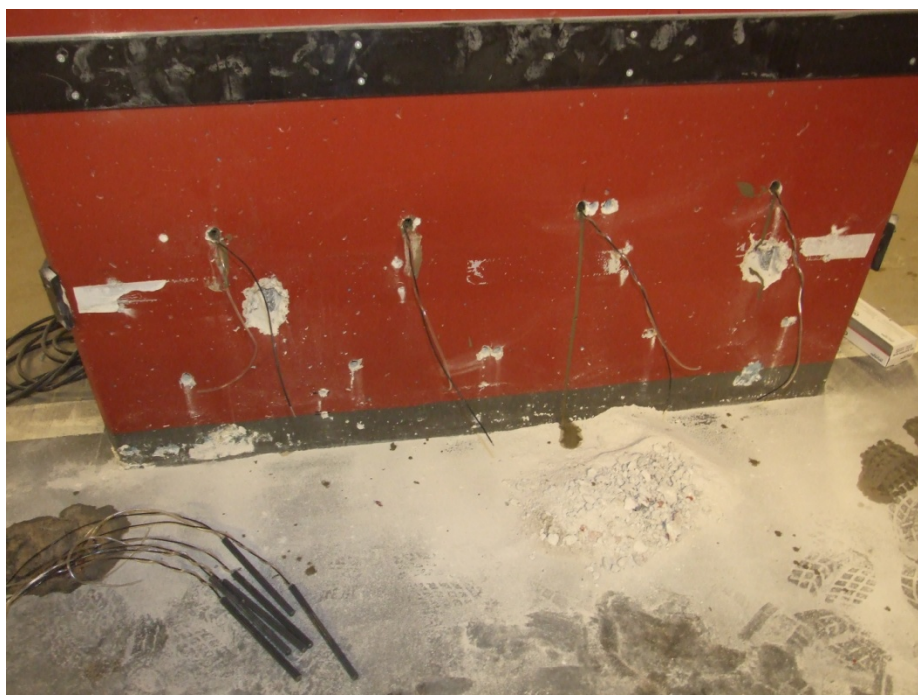
Figur 33 Pelare C4 med inmonterade insticksanoder av märket Ebonex Plus (220 mm från golvytan) (Foto: B Sederholm)
