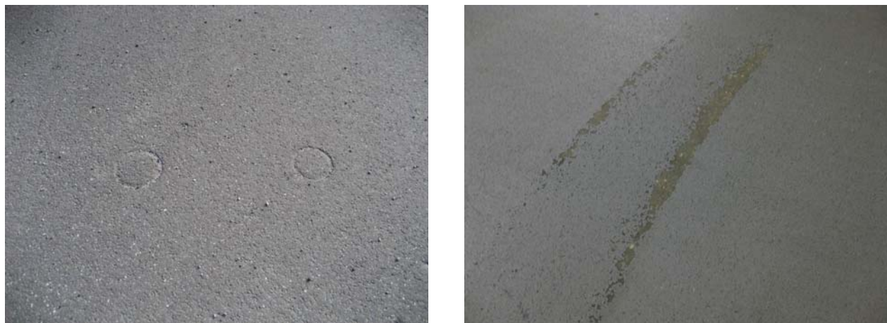
Figur 2 Exempel på skador för gjutasfalt (t v) respektive hårdplast (t h) [1]
