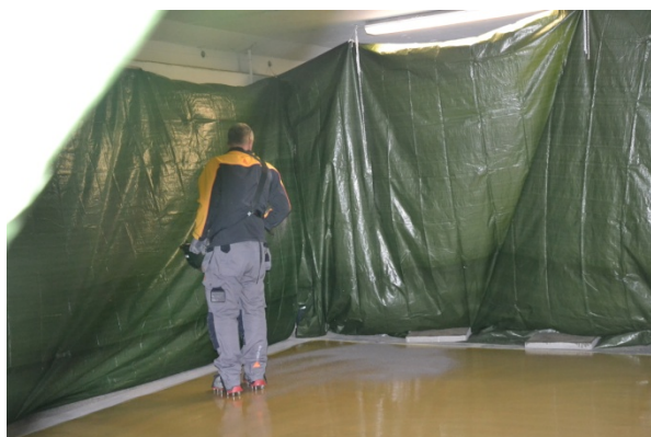
Figur 11 Slitlagerbeläggnings fullströas med sand (Foto: Y Edwards)
