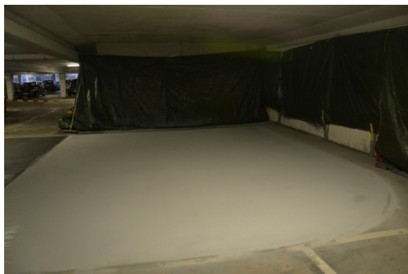
Figur 26 Färdig provyta med Polyurea Micorea S3 (Foto: Y Edwards)
