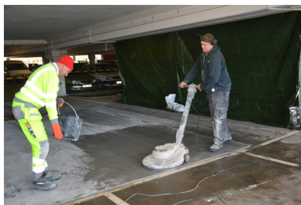
Figur 9 Densitbeläggningen slipas veckan efter utläggning (Foto: Y Edwards)
