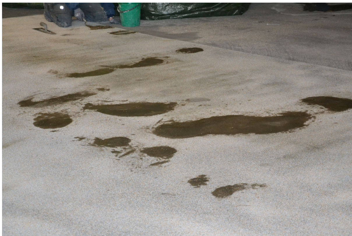
Figur 21 Lagning med akrylmassa på yta 7 inför beläggingsarbetet (Foto: Y Edwards)
