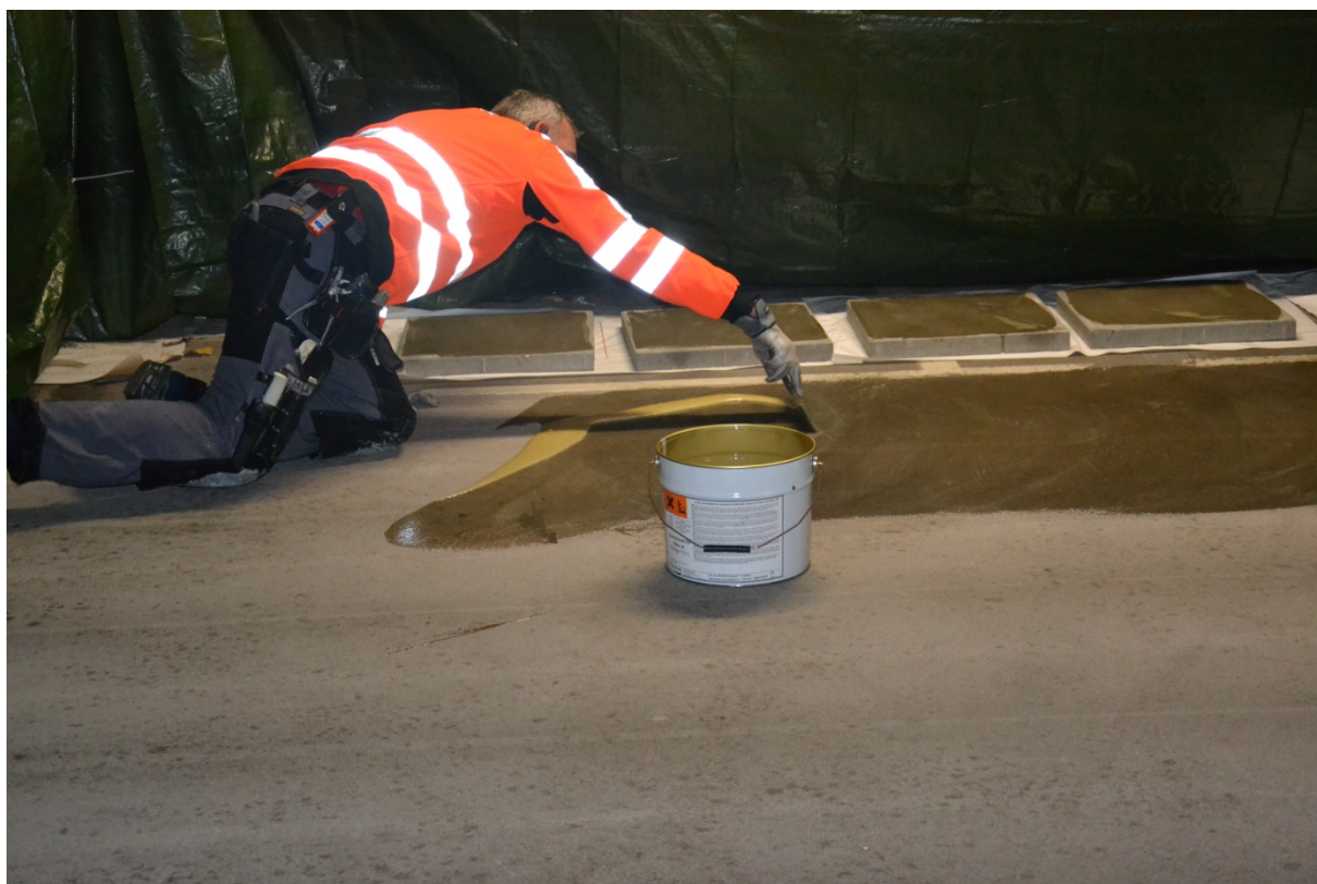
Figur 17 Utläggning av primer Deckshield EP (Foto: Y Edwards)
