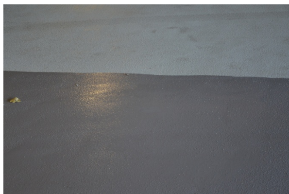
Figur 18 Färdig grå provyta med Deckshield ID från Flowcrete (Foto: Y Edwards)
