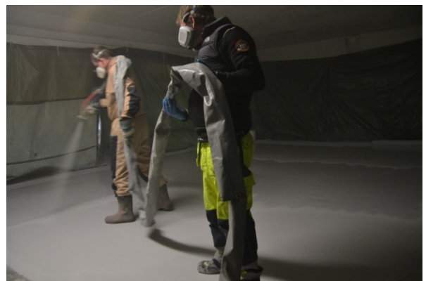
Figur 25 Polyurea Micorea S3 sprutappliceras med ordentligt skydd omkring provytan (Foto: Y Edwards)
