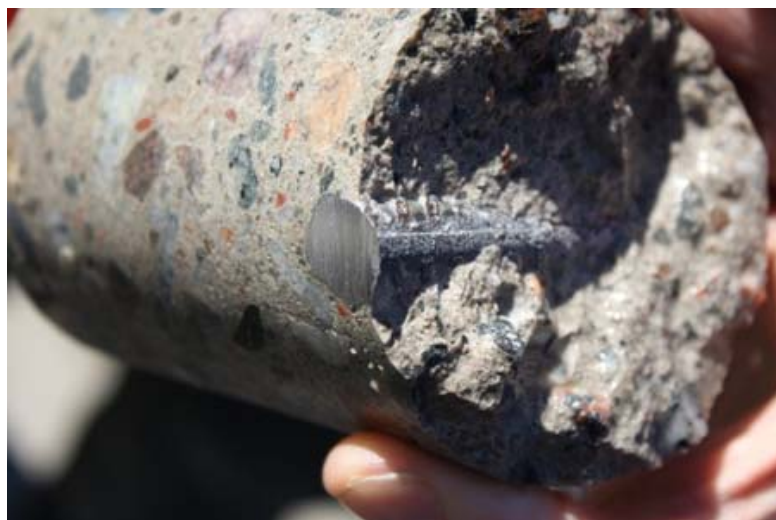
Figur 38 Tekniskt brott vid armeringen. Täckande betongskikt ca 70 mm (Foto: CBI)
