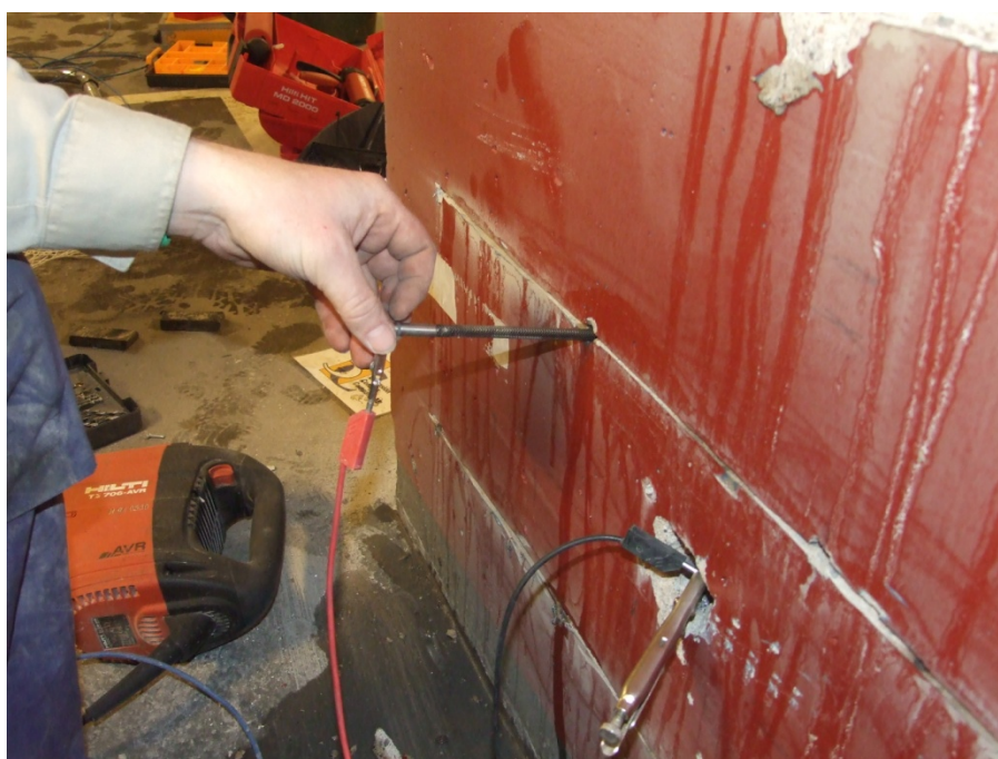
Figur 34 Montering av insticksanoder av märket DurAnod 3 i pelare C3 (510 mm från golvytan) (Foto: B Sederholm)
