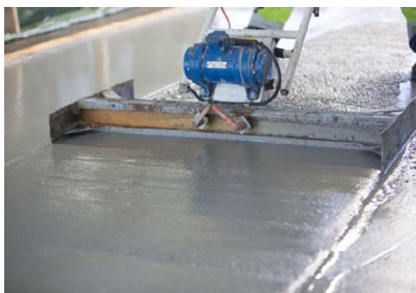
Figur 8 Utläggning av Densit beläggning med vibrering (Foto: SBK)
