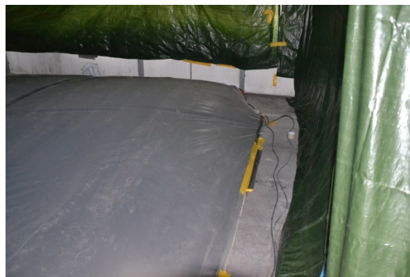
Figur 27 Mapefloor PU Flexibinder under utläggning respektive härdning (Foto: Y Edwards)
