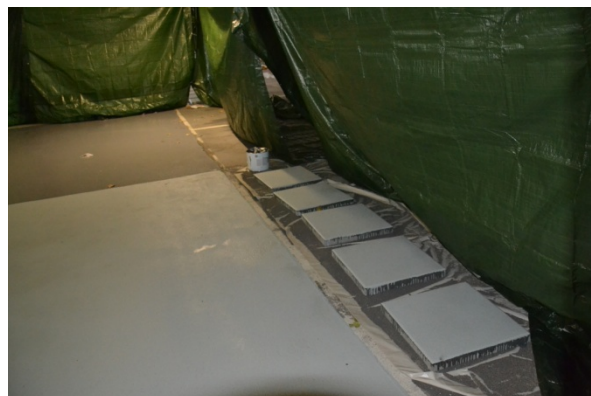
Figur 20 Färdig provyta med Conideck 2255 samt provplattor (Foto: Y Edwards)
