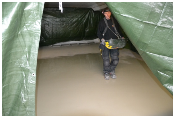
Figur 14 Slitlagerbeläggningen fullströas med sand (Foto: Y Edwards)
