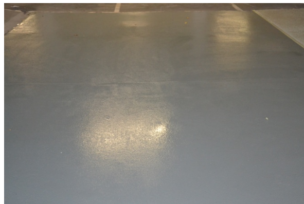
Figur 13 Färdig grå provyta Sikafloor 375 med topplack (Foto: Y Edwards)
