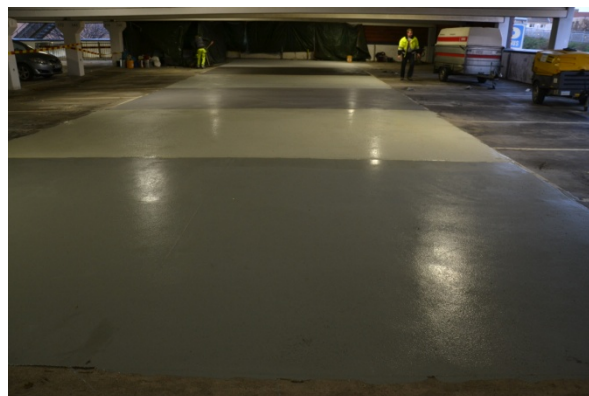
Figur 42 och 43 Färdig provläggning i Kvillegaraget (Foto: Y Edwards)
