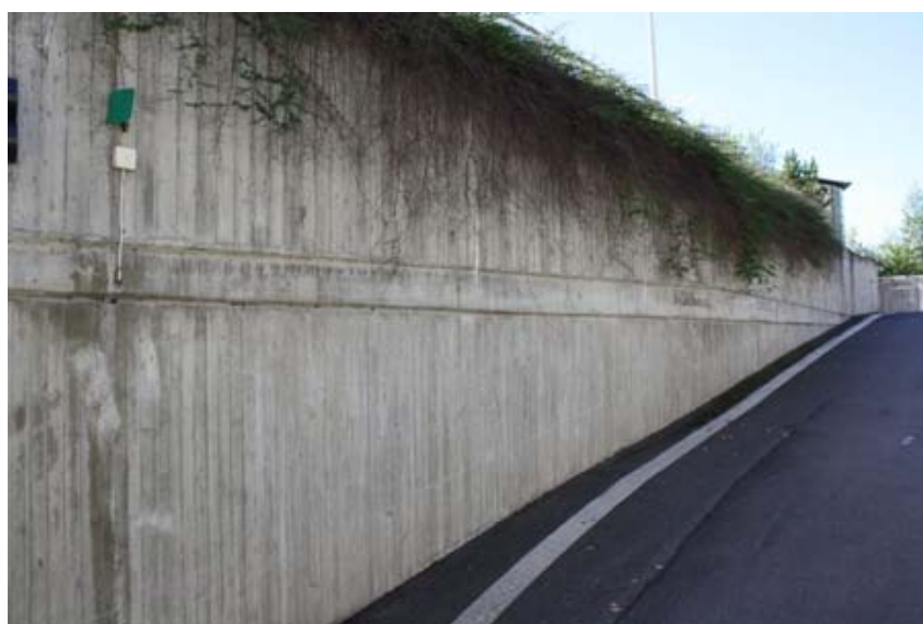
Figur 36 Slitbetongens tjocklek framgår av bilden, ca 40 cm (skikt mellan underjordsgarage och stödmur). Under slitbetongen finns någon form av isolering eller tätskikt (Foto CBI)
